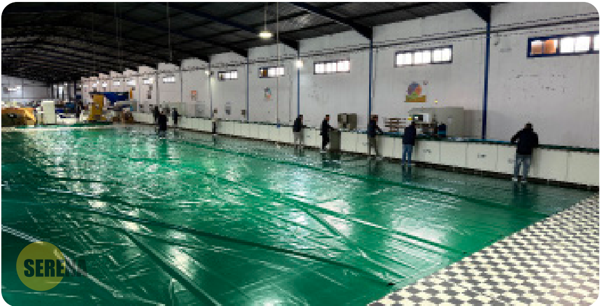
Herstellung eines 1000 m 3 Tanks
