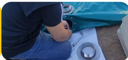
En cas de raccordement hors sol, il faut utiliser un tuyau souple d'au moins 3 mètres. Il est formellement déconseillé d'utiliser un tuyau rigide sous peine d'endommager les brides et la citerne.
