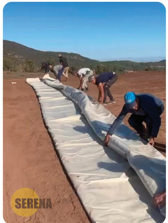
Une fois déployée, soulever les angles opposés et secouer légèrement pour créer un tapis d'air. Si l'emplacement de la citerne doit être ajusté, ne pas trainer la citerne mais procéder en la secouant.
