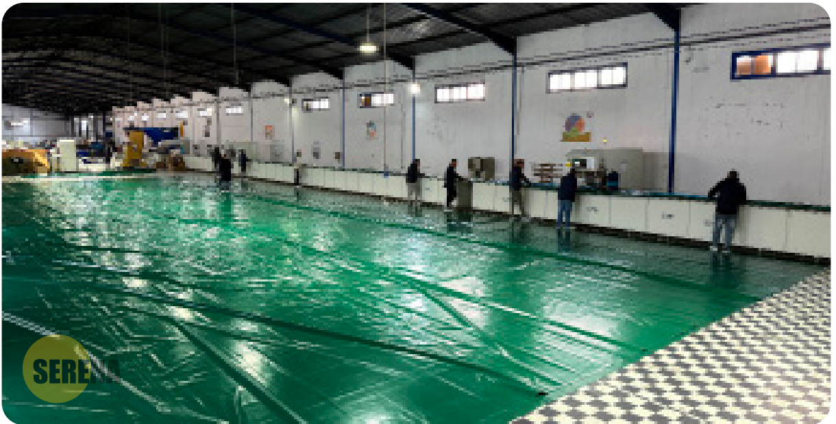
Fabrication d'une citerne de 1000 m 3
