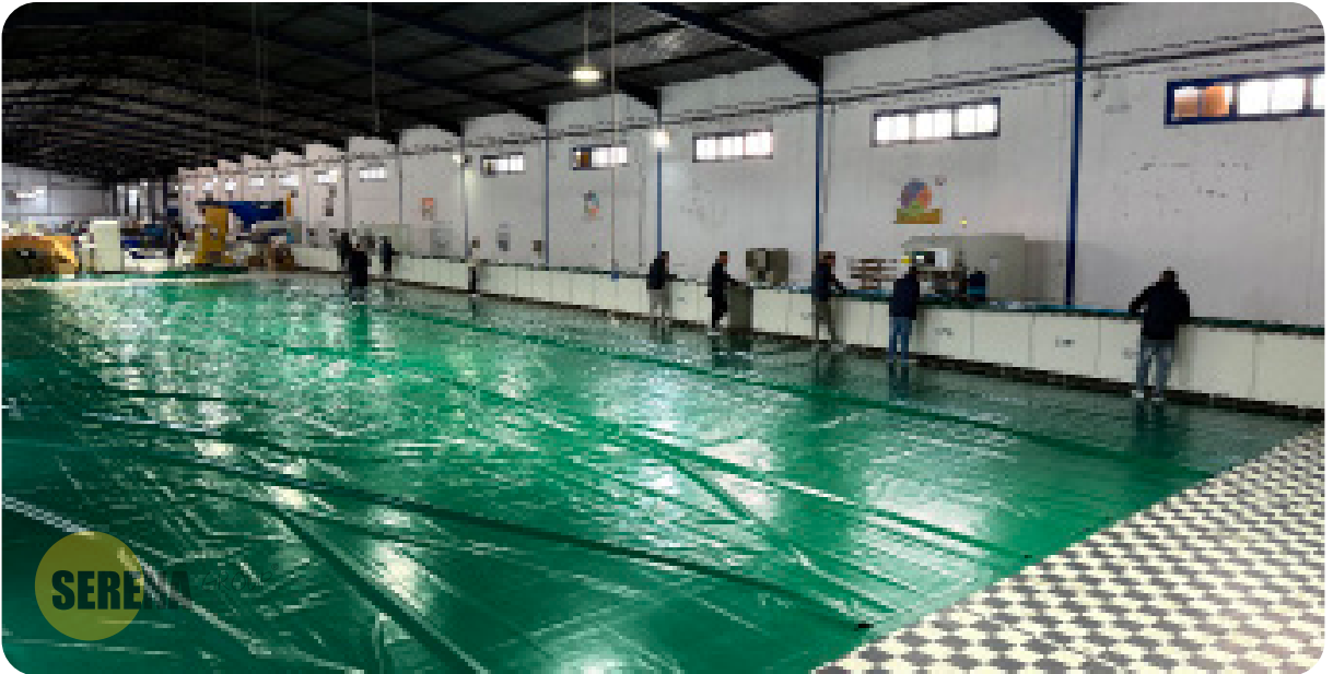
Herstellung eines 1000 m 3 Tanks
